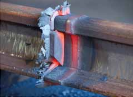
Снятие грата на сварном рельсе
