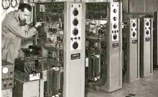
Проверка устройств управления «Variotron»
