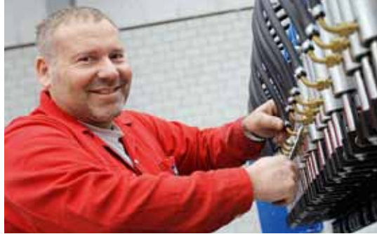
Montage d'une installation à Schlieren
