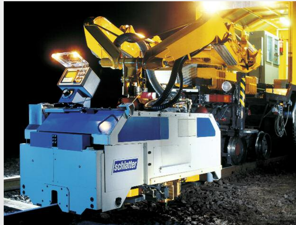
Ein mobiles Schlatter Schienenschweissystem beim Einsatz im Gleis.
